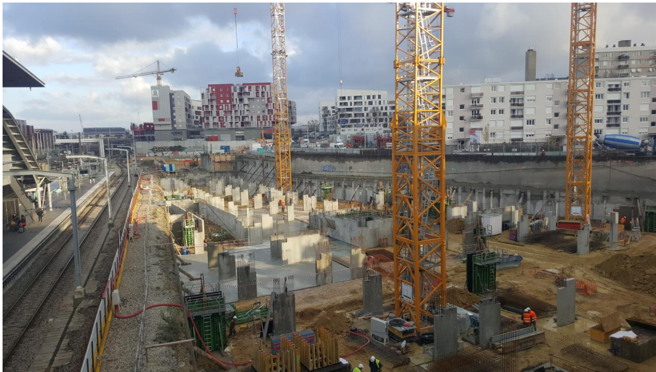
Vue sur le chantier de Cœur de Quartier et la cité des Provinces Françaises @auteure novembre 2017
